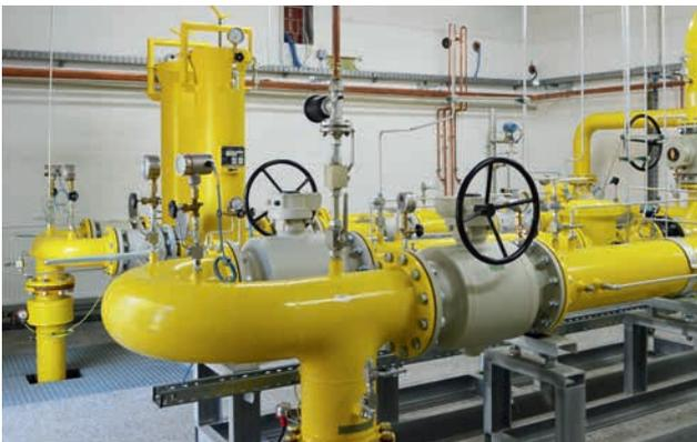
Gas-Druckregelanlage auf Werksgelände
